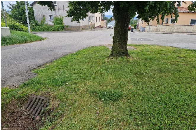
Einlassbauwerk am Graben rechts der Römerstraße
