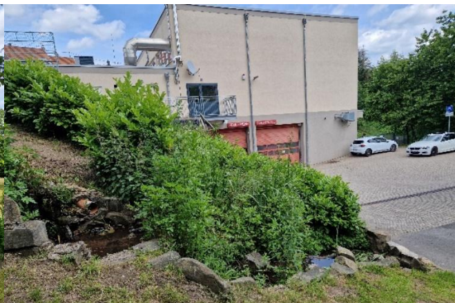
Glan und dahinter tieferliegendes Gebäude der Feuerwehr
