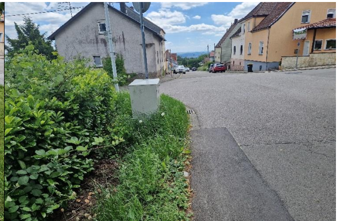
Graben und Einlass vor der Kreuzung an der Römerstr.
