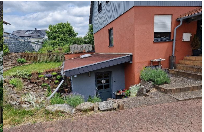
Beispiel für ein tieferliegendes, pot. gefährdetes Objekt
