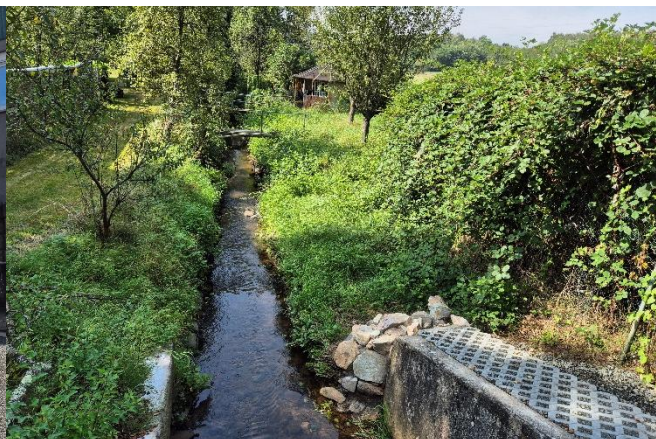
Bexbach in Fließrichtung unter dem Durchlass
