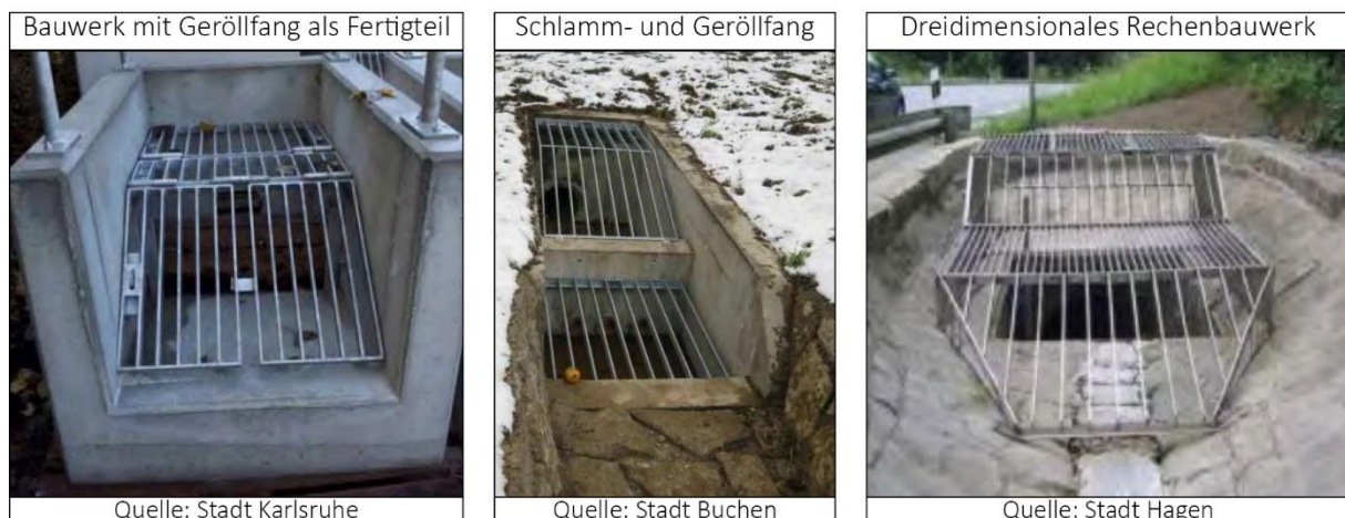
Abb. 6: Beispielhafte Verbesserung von Einlaufbauwerken an Gräben und vor Verrohrungen
