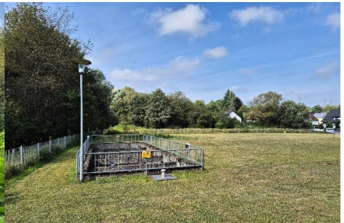
Absetzbecken der Stadtwerke schlägt in den Bach ab
