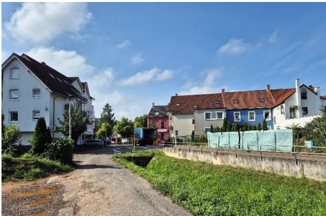
Einlass in die Bachverrohrung in der Bildmitte
