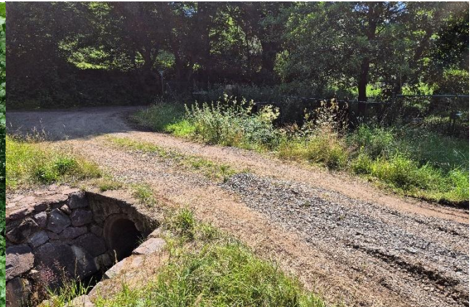
Wegedurchlass südlich der Mündung des Tiefenbaches
