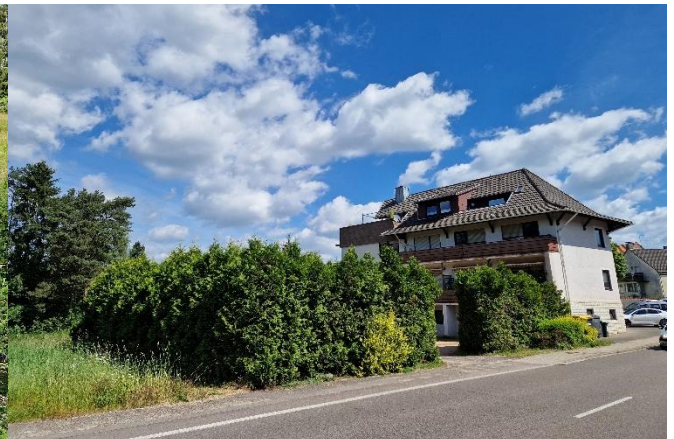
Potenziell gefährdete Bebauung an der Jägersburger Str.
