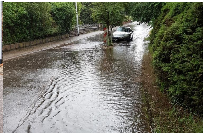
Überlastung des Kanals in der Mühlenstr. nach Starkregen
