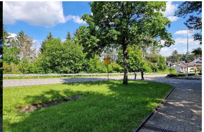
Einlassbauwerk unterhalb des Friedhofs
