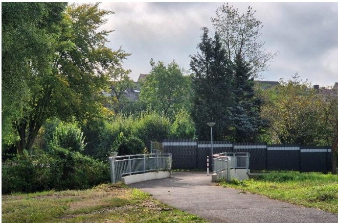
Fußgängerbrücke über den Bexbach auf Höhe Maxstraße
