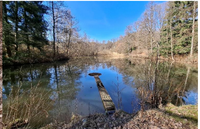
Weiheranlage im Hauptschluss des Rolschbaches
