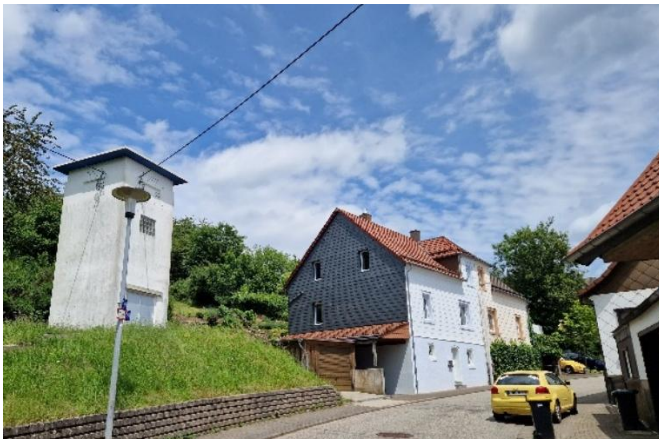
Trafostation an Dunzweilerstraße
