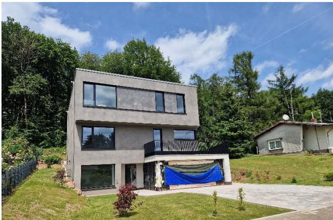
Neubau in Tiefenlinie
