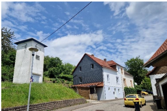
Trafostation an Dunzweilerstraße
