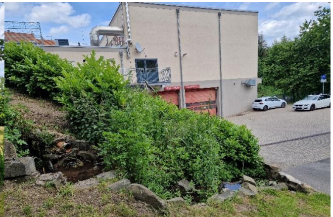
Glan und dahinter tieferliegendes Gebäude der Feuerwehr
