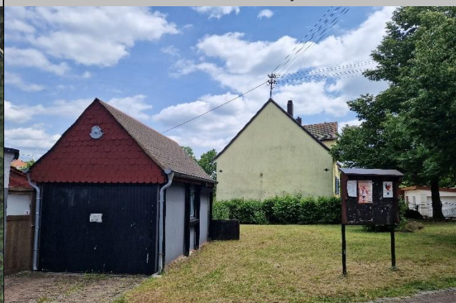
Verrohrter Abschnitt des Glans am Objekt Dunzweilerstr. 8
