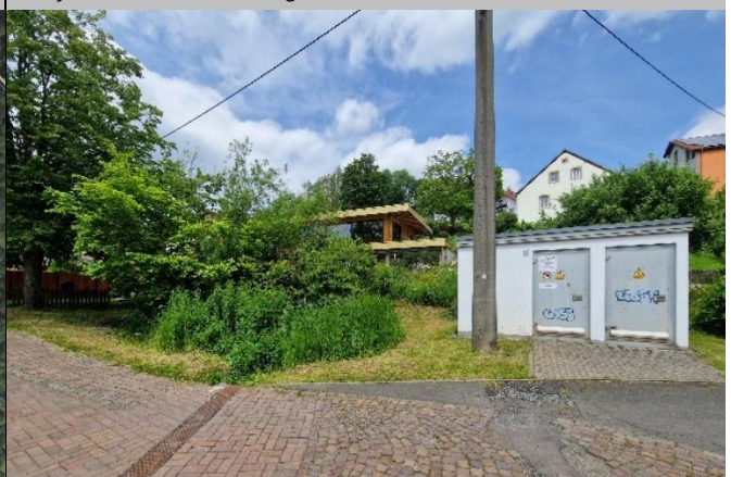
Trafostation am Seitengewässers des Glans
