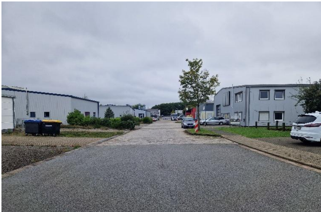
Blick nach Nordosten vor Gebäude Nr. 202
