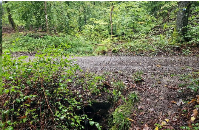
Weg über dem Durchlass des Dorfbrunnenbaches
