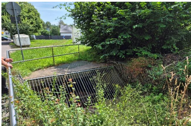
Einlassbauwerk des Gewässers
