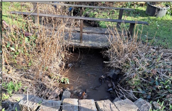
Private Holzbrücke über den Rolschbach
