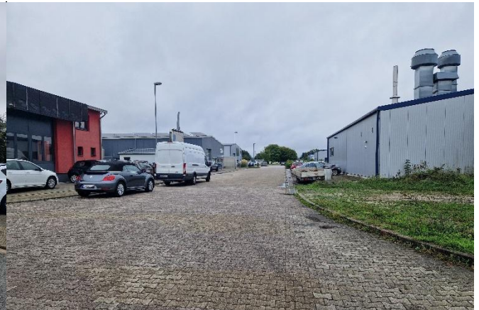
Mögl. Abflussbereich nach Südwesten bei Gebäude Nr. 105
