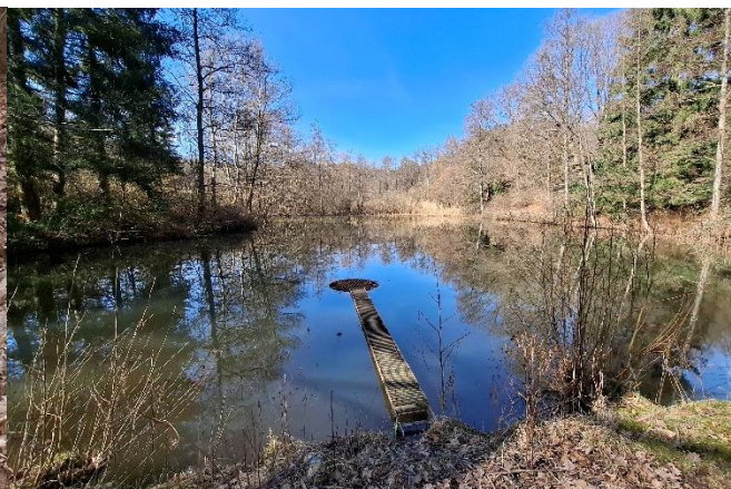
Weiheranlage im Hauptschluss des Rolschbaches
