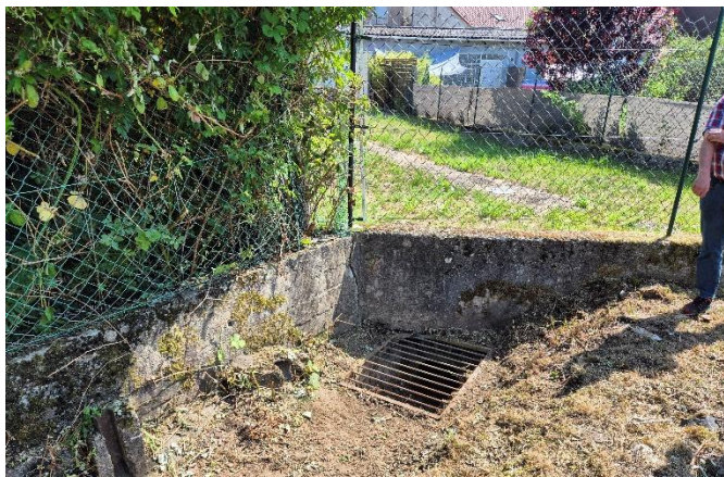
Einlass in die Bachverrohrung des Rolschbaches
