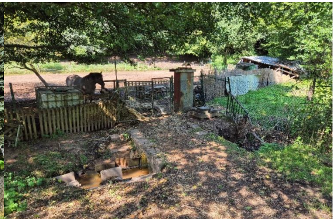
Durchlass an Grundstücken außerhalb der Ortslage
