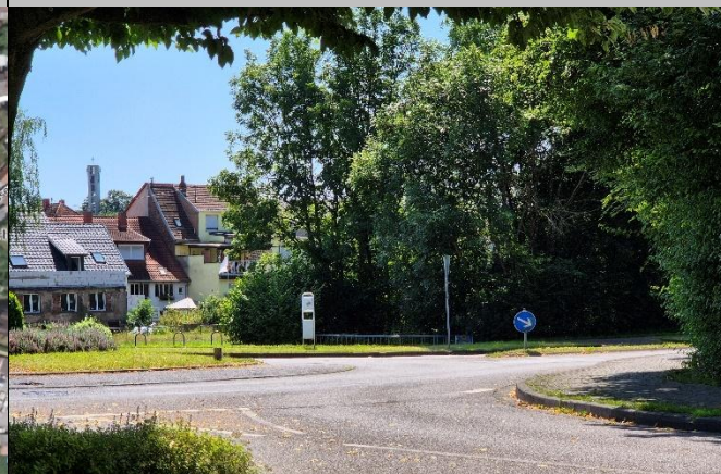
Blick entlang der Bachverrohrung zur Bexbach-Mündung
