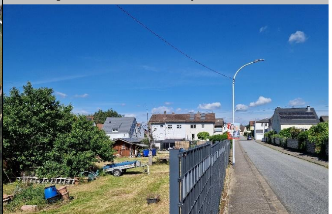
Bebauung südlich der Schwannstraße
