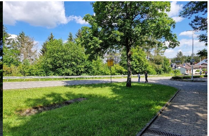
Einlassbauwerk unterhalb des Friedhofs
