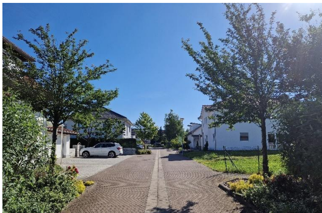
Entwässerung mit Mittelrinne und negativem Dachprofil
