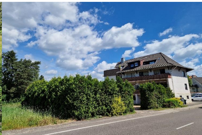
Potenziell gefährdete Bebauung an der Jägersburger Str.
