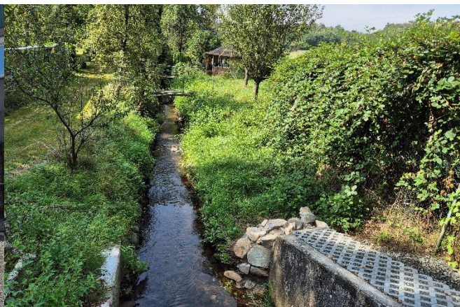
Bexbach in Fließrichtung unter dem Durchlass
