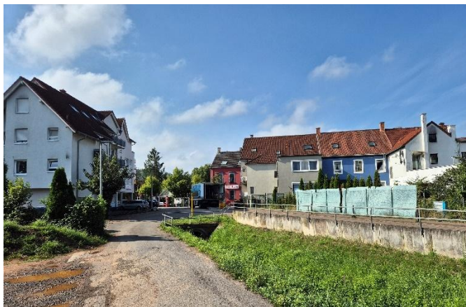
Einlass in die Bachverrohrung in der Bildmitte
