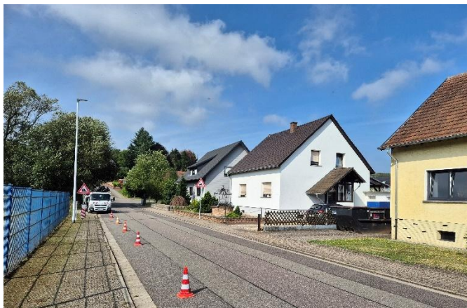
Betroffener Bereich/ Senke in der Kolpingstraße
