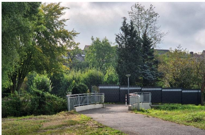
Fußgängerbrücke über den Bexbach auf Höhe Maxstraße
