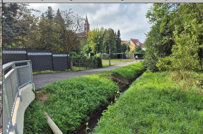
Blick in Fließrichtung zur Verrohrung Rathausstraße
