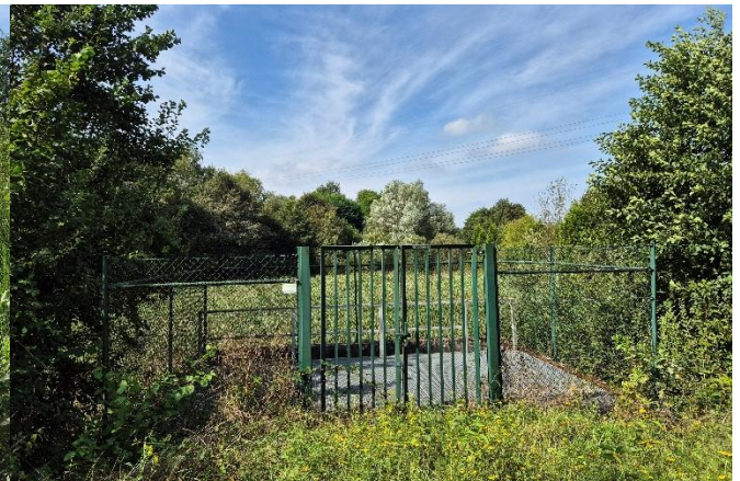
Rückhaltebecken zwischen Tankstelle und Bahndamm
