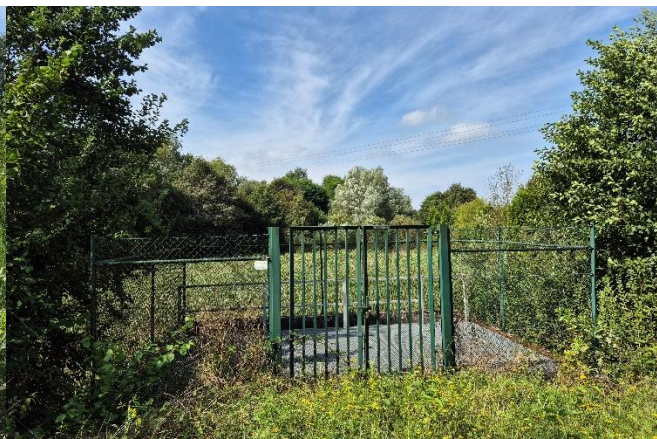
Rückhaltebecken zwischen Tankstelle und Bahndamm
