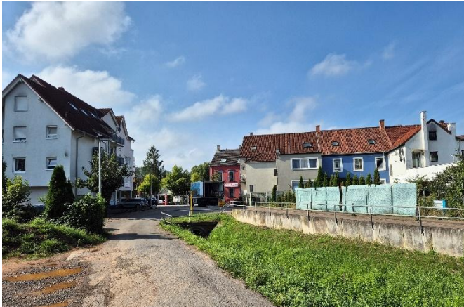
Einlass in die Bachverrohrung in der Bildmitte
