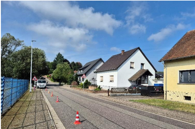
Betroffener Bereich/ Senke in der Kolpingstraße
