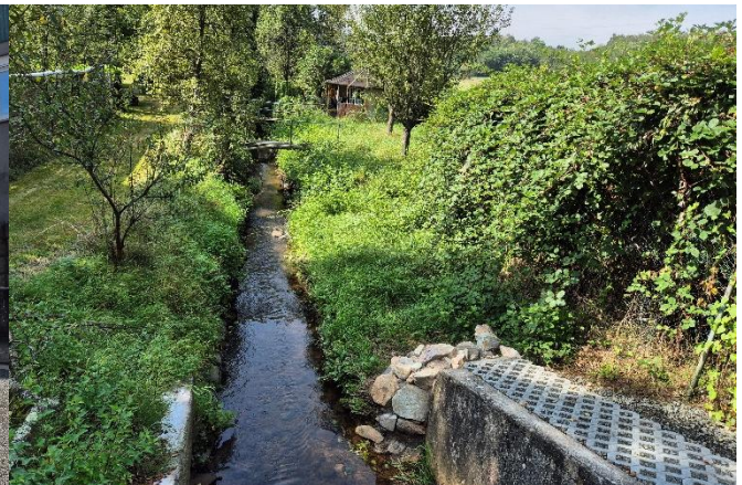
Bexbach in Fließrichtung unter dem Durchlass
