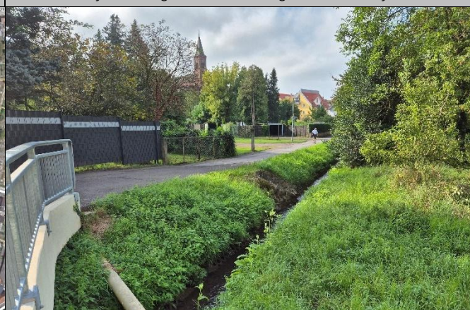
Blick in Fließrichtung zur Verrohrung Rathausstraße
