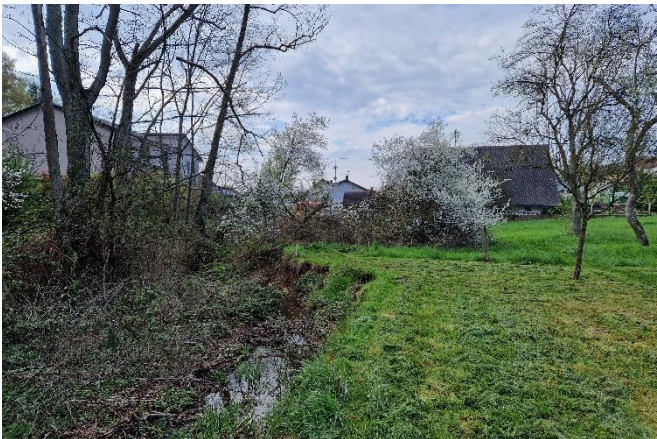
Gewässer und Retentionsbereich vor dem Einlassbauwerk
