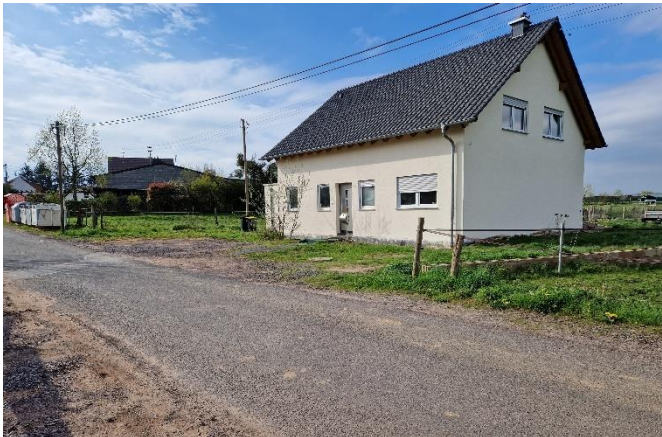
Bebauung im Bereich des Durchlasses
