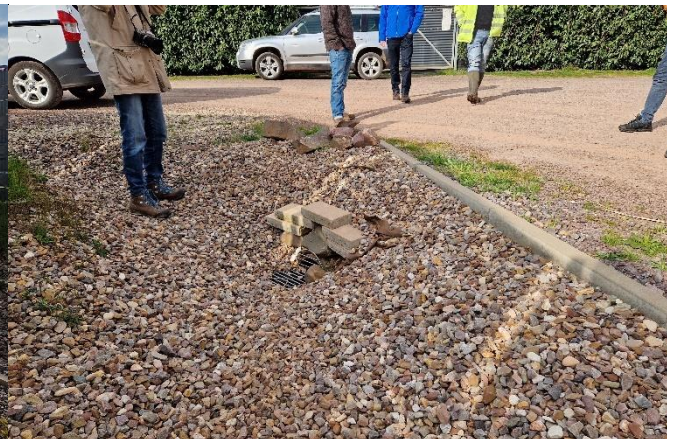
Zu optimierender Einlassbereich in den Kanal
