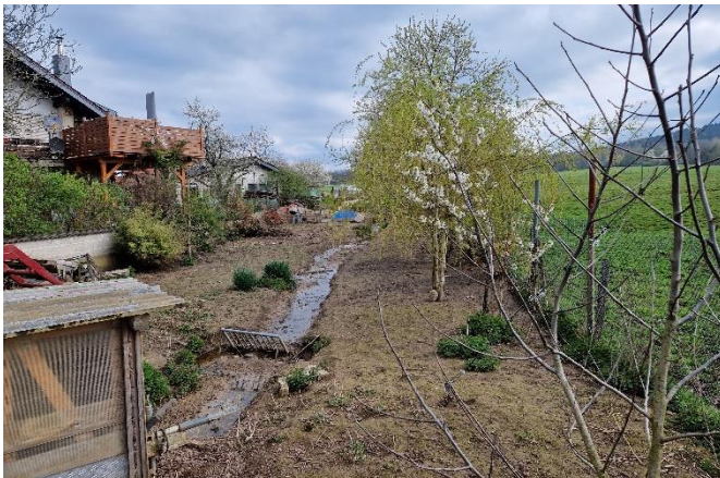
Graben auf Privatgelände
