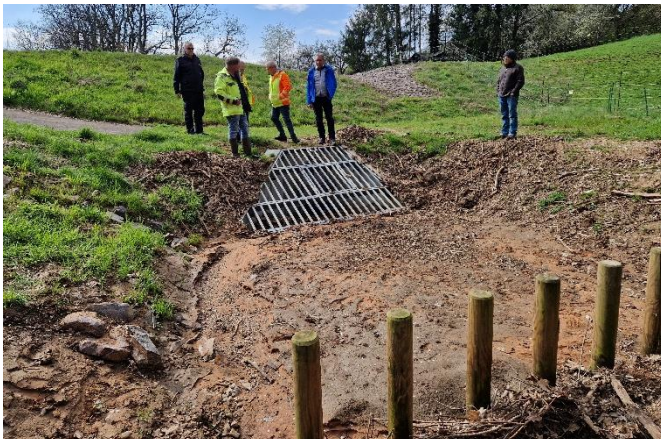
Rückhaltebecken und Treibgutfang am Zimmerbach
