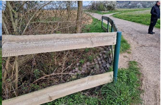
Auslassbereich des Zimmerbaches am Wirtschaftsweg
