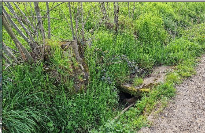
Entwässerungsgraben am Durchlass des Zimmerbaches
