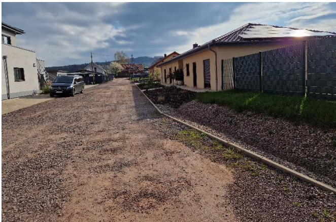
Entwässerungsgraben entlang der Straße
