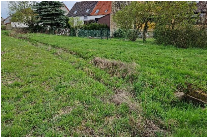
Wall und Einlassbauwerk rückseitig der Wohngebäude
