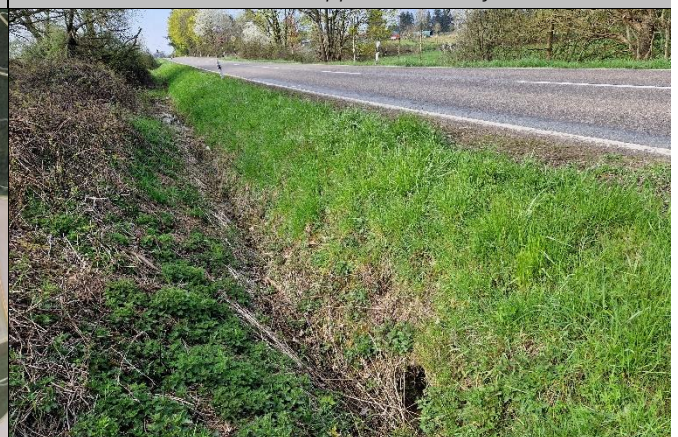
Graben und Durchlass an Düppenweilerstraße
