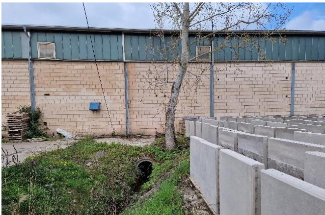
Blick auf die Bachverrohrung des Kindelfloß'
