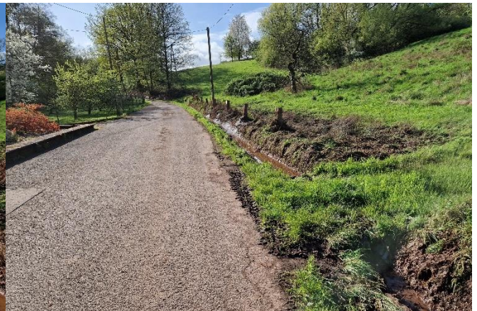
Ausgebaggerter Graben ggü. Weierstraße 7
