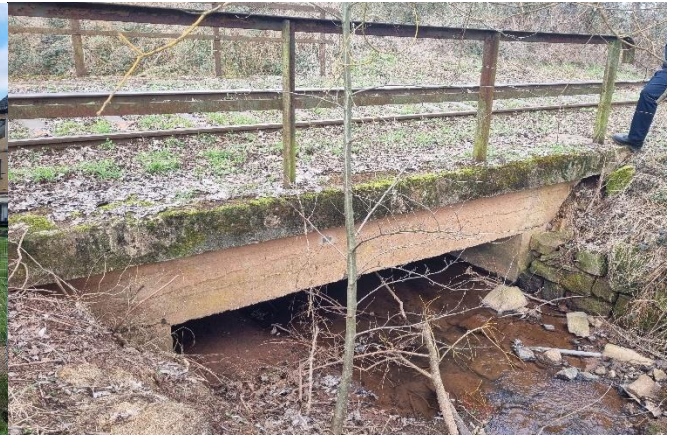
Bachdurchlass Herrnbach im Bahndamm
