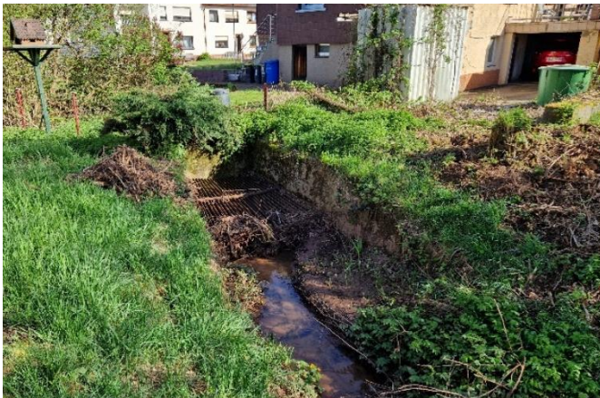
Einlassbauwerk südlich der Dorfstraße
