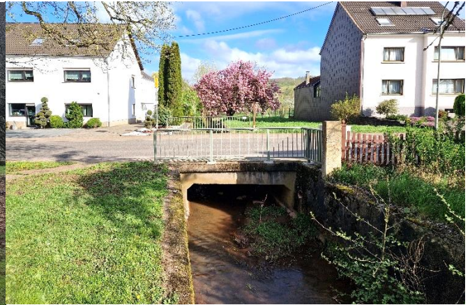
Straßendurchlass an der Dorfstraße
