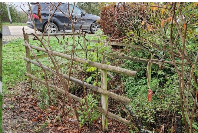
Einlassbereich der Verrohrung vor dem Kerlinger Weg
