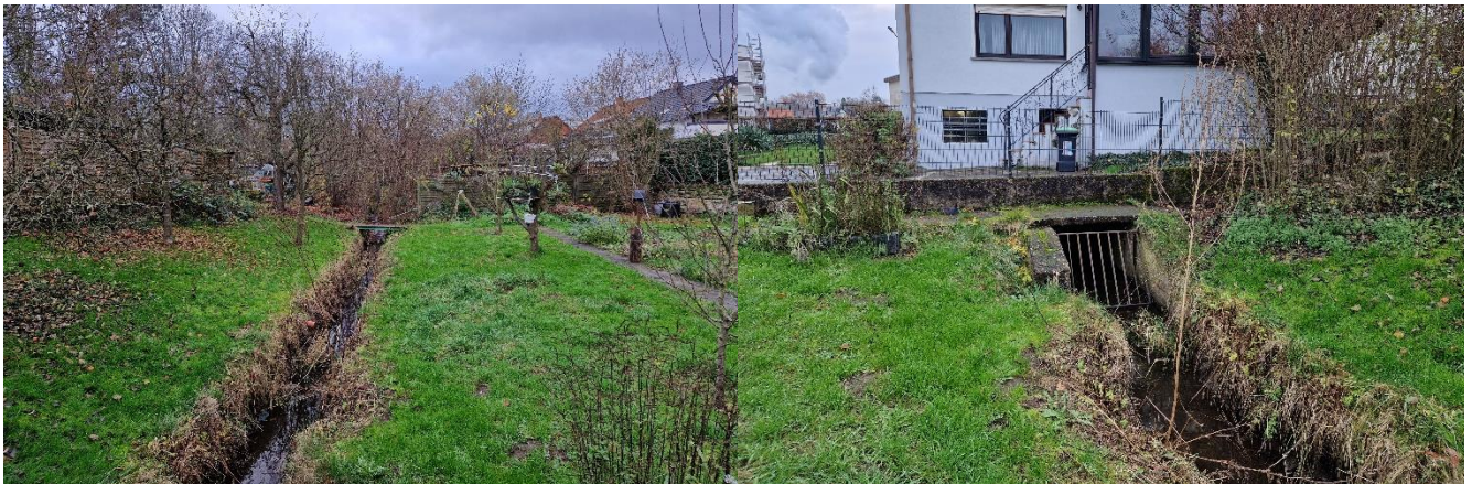
Blick gg. die Fließrichtung auf den Bach vor dem Einlass
