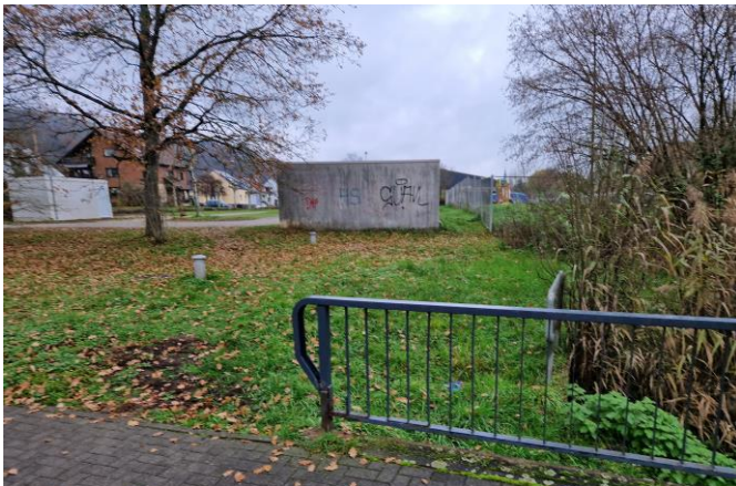
Auslassbereich am nördlichen Durchlass in der Straße
