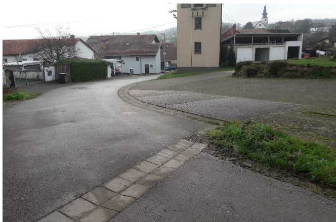
Im Kurzath: Querrinne und Kanaleinlass
