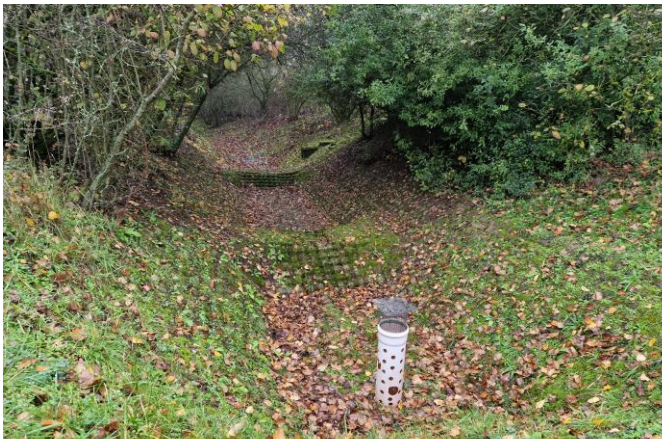
Kanaleinlassbereich und Blick in den Graben (gg. Fließrtg.)
