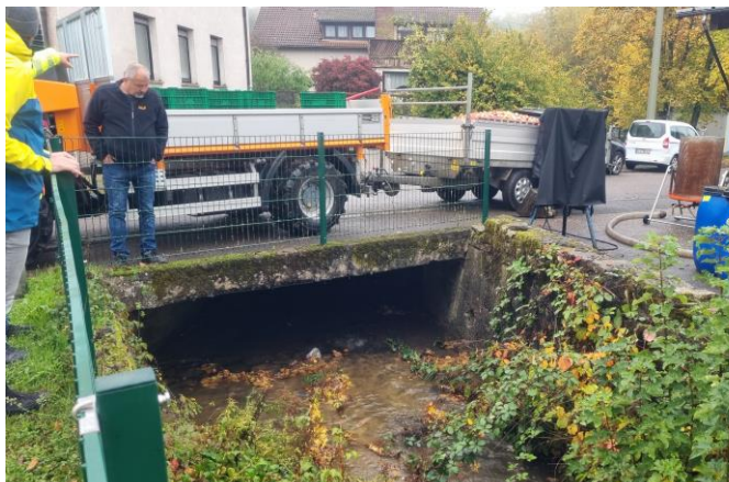
Durchlass „Im Ecken“
