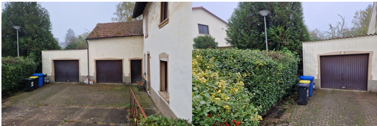
Saarlouiser Str. 77: tieferliegender Bereich vor der Straße
