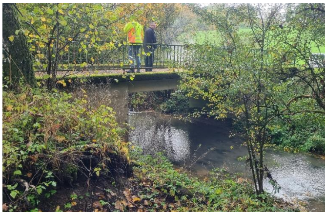
Durchlassbauwerk an der Königsmühle
