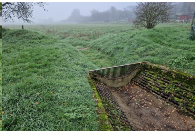
Blick gegen die Fließrtg. vom Einlassbauwerk auf den Bach
