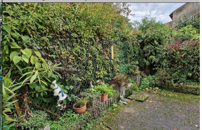
Überbauung des Bachlaufs, Einlassbereich hinter dem Zaun
