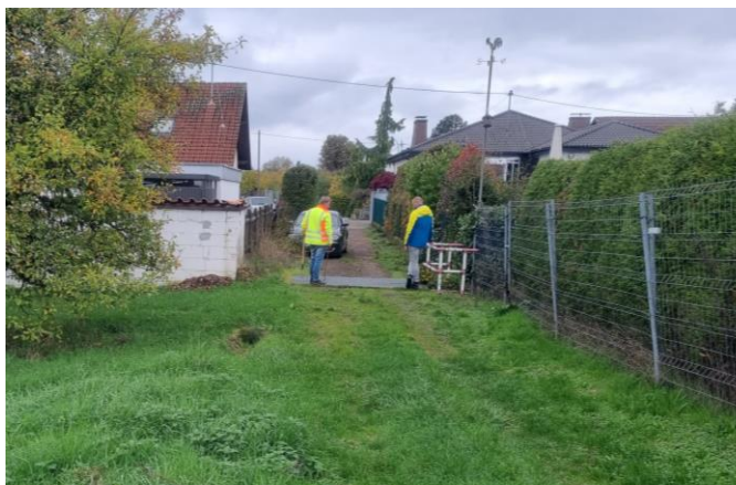
Anlage zur Außengebietsentwässerung: Waldstr. 14-16
