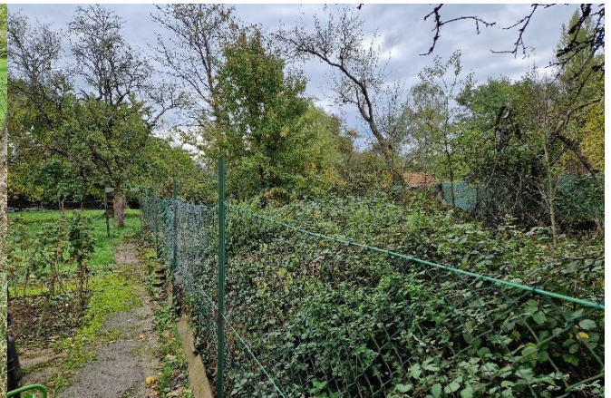
Nicht unterhaltener Bachlauf (links) vor der Verrohrung
