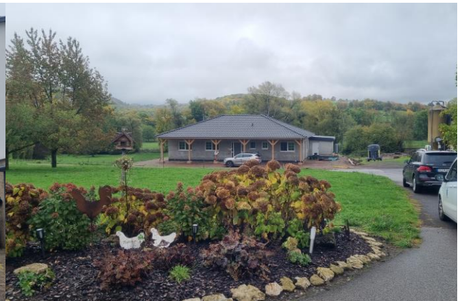
Neubau östlich der Straße oberhalb des Ihner Baches
