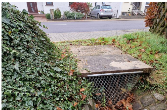
Einlassbauwerk vor der Schloßstraße
