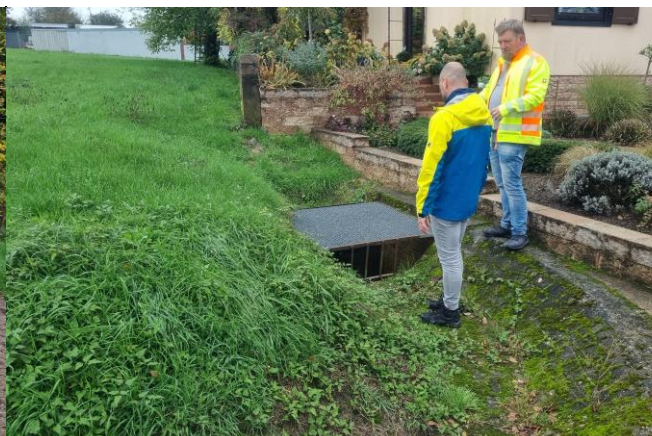
Einlassbauwerk am Ortsrand/ Feldstraße
