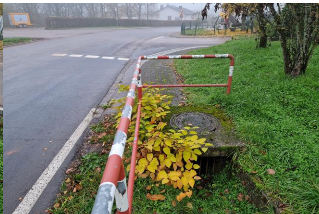
Einlassbauwerk vor der Einmündung zum Siercker Weg
