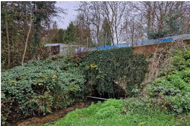
Durchlass des Baches im Fußweg
