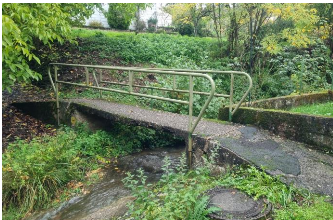
Brücke im Abschnitt vor Durchlass „Zum Hatzenbüsch“
