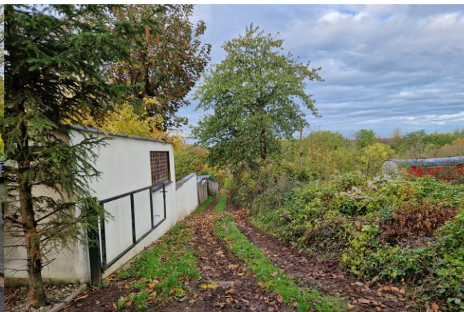
Schadarmaer Abflussweg entlang der Bebauung
