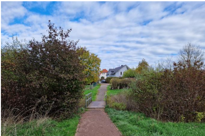
Weinbach-Durchlass in Verlängerung des Marienweges
