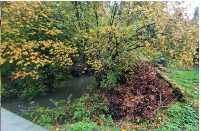
Einlassbereich am Brückendurchlass
