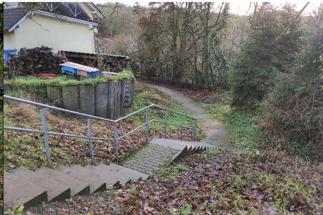
Potenzieller Notabflussweg über den Fußweg
