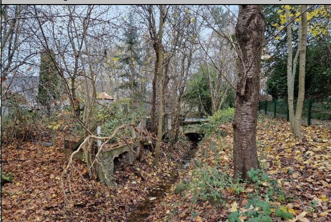
Verrohrung hinter dem Grundstück Vom-Stein-Straße
