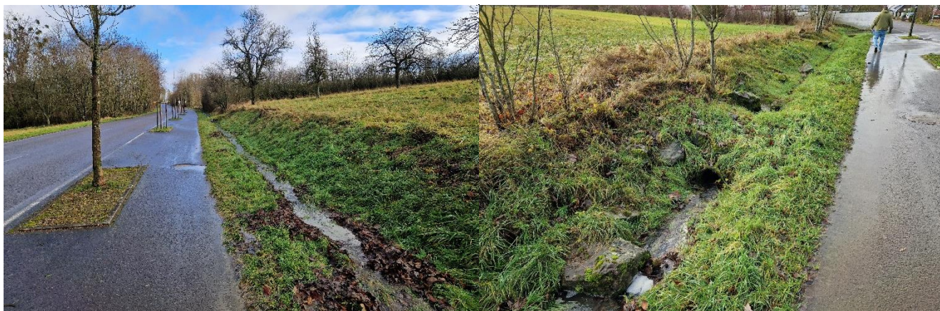
Graben am Oberlimberger Weg: Blick nach Nordosten
