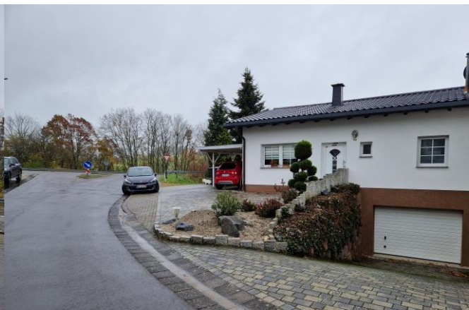
Gefährdetes Objekt Aubachweg 1
