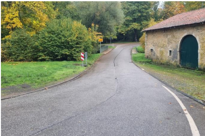
Ihner Bach, Blick auf Straßendurchlass an der L 354
