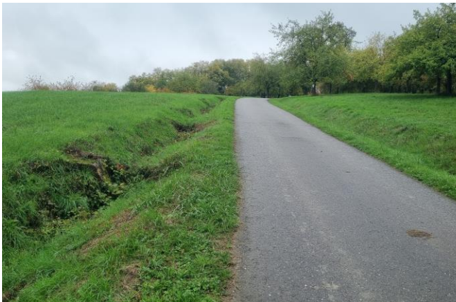
Wegeseitige Gräben, Blick nach Südwesten
