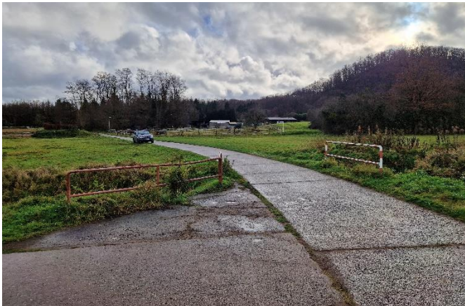
Bachkreuzung im Weg
