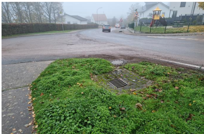
Kanaleinlass links der Straße, Blickrichtung Schulstraße
