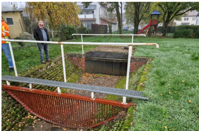
Einlassbauwerk: Blick in Fließrtg. bis zum Kinderspielplatz
