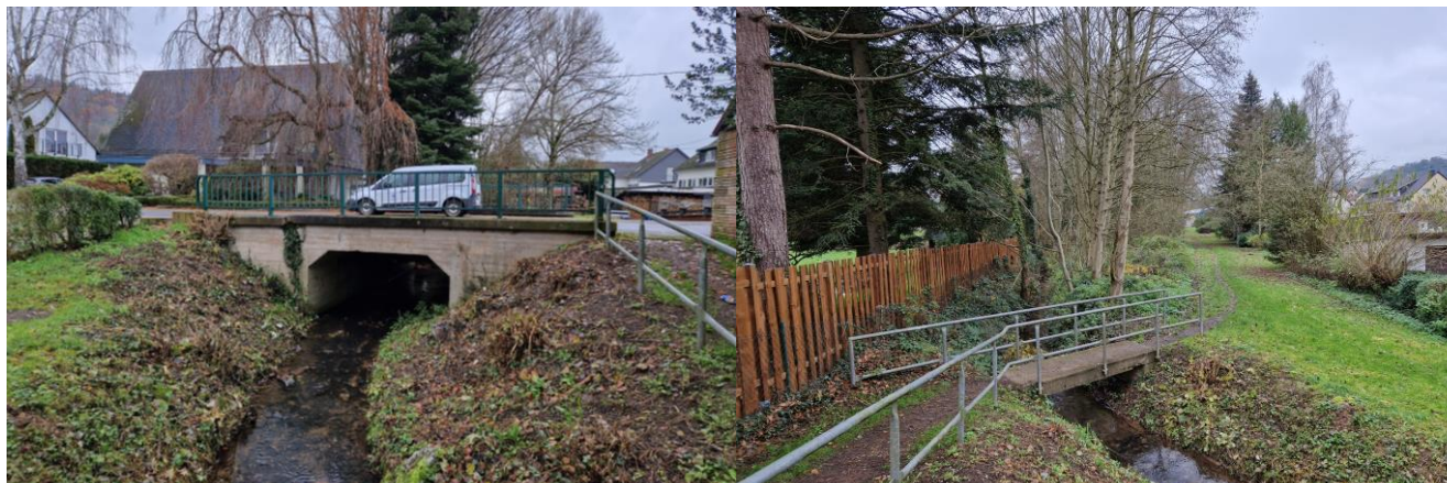
Blick in Fließrichtung auf das Durchlassbauwerk
