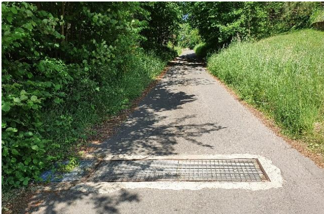
Einlassbauwerk am Ende der Straße „Am Grauenstein“
