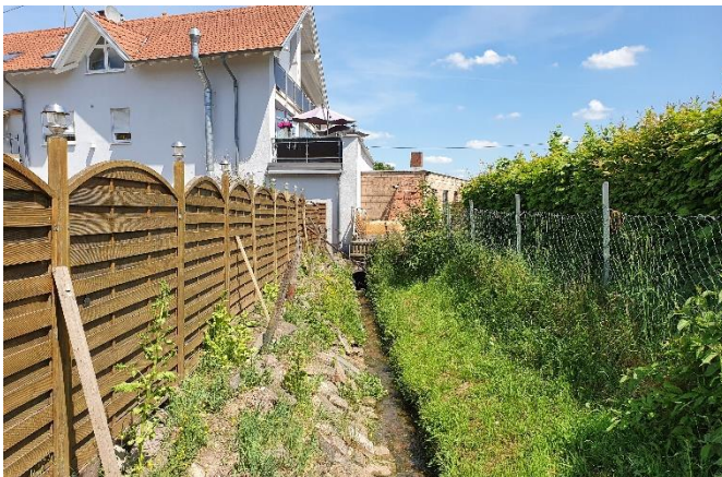
Bachlauf auf den Einlass in die Verrohrung Wahlener Str.
