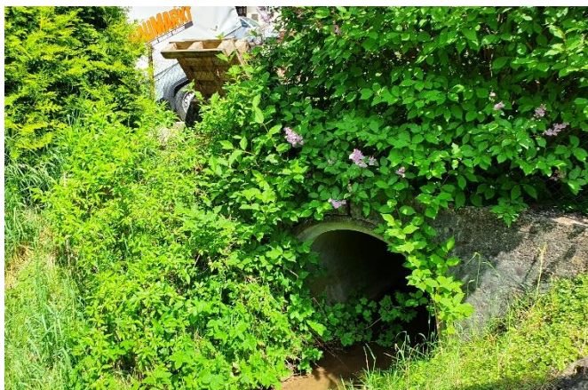
Durchlass in der Wahlener Straße
