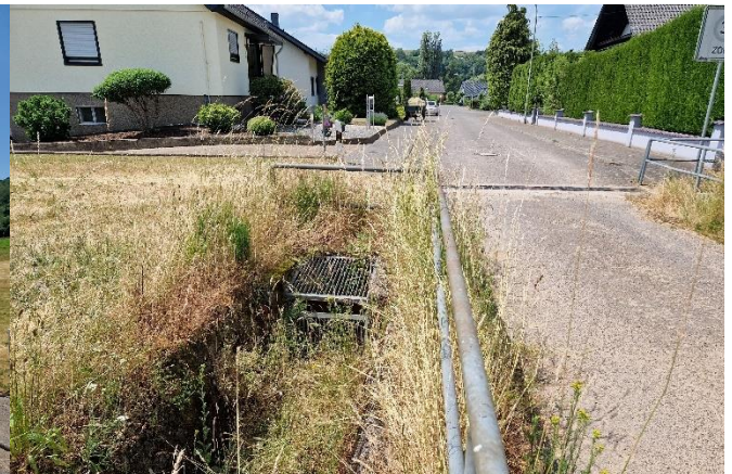
Einlassbauwerk links vor der Ortslage: Zur Ziegelhütte 30
