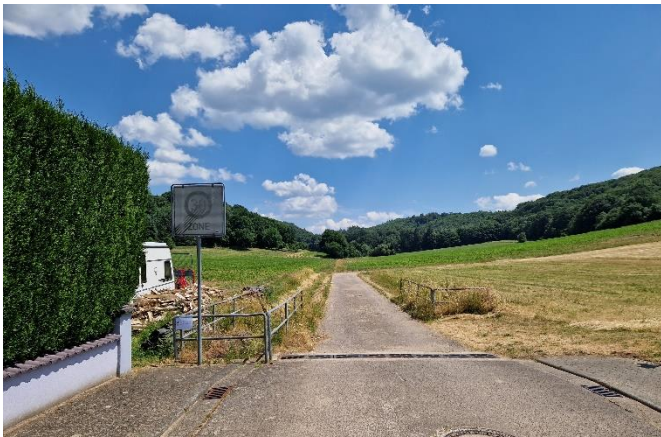
Einlassbauwerke am, Rinne im Weg: Blick ins Außengebiet
