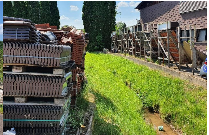
Gewässer vor dem Straßendurchlass
