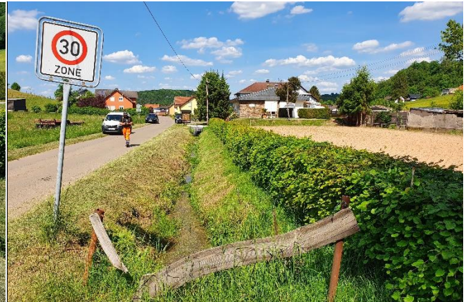
Bachlauf zwischen Überfahrt und Einlassbauwerk
