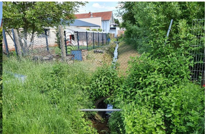
Bachlauf oberhalb der Verrohrung (Blick in Fließrtg.)
