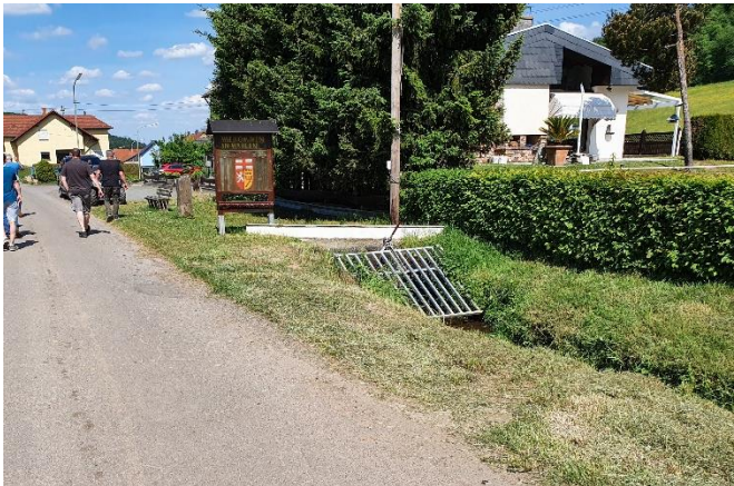
Einlassbauwerk im Bereich „Im Neef 17“
