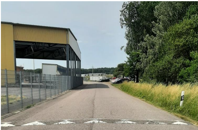
Bereich des Bachdurchlasses in der Straße, Fließrtg. v.l.n.r.
