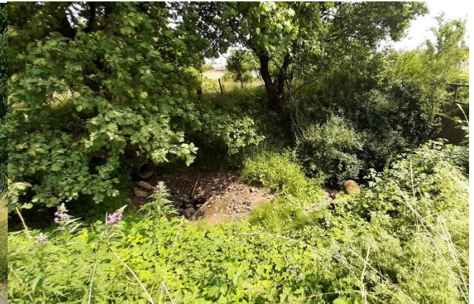
Einlassbereich vor dem Bachdurchlass (ganz rechts)
