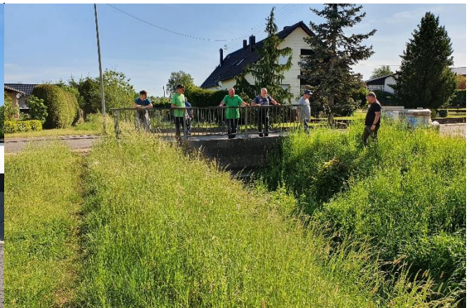
Blick in Fließrichtung auf das Brückenbauwerk
