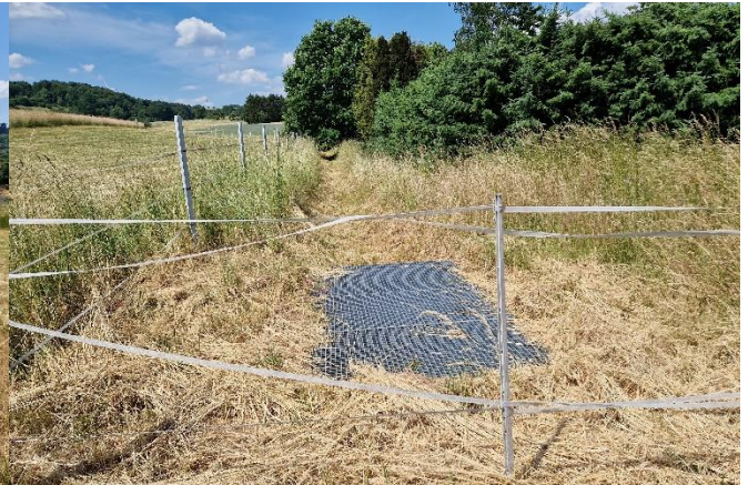
Blick auf das Bauwerk und den zuführenden Graben
