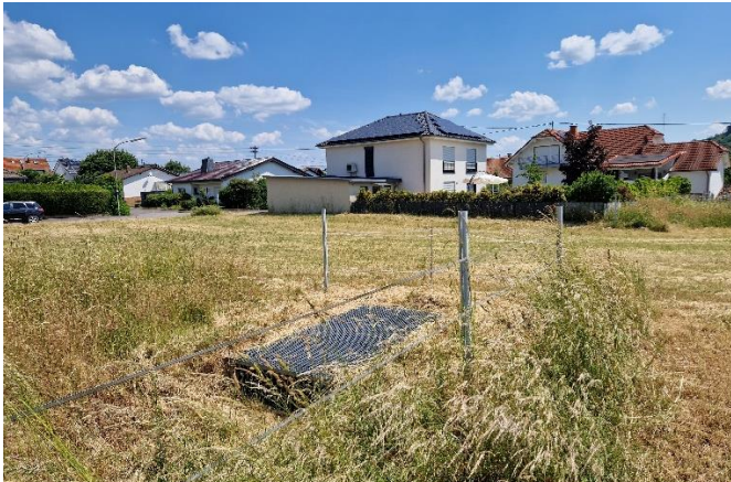
Einlassbauwerk hinter unbebautem Grundstück Bornstr. 3
