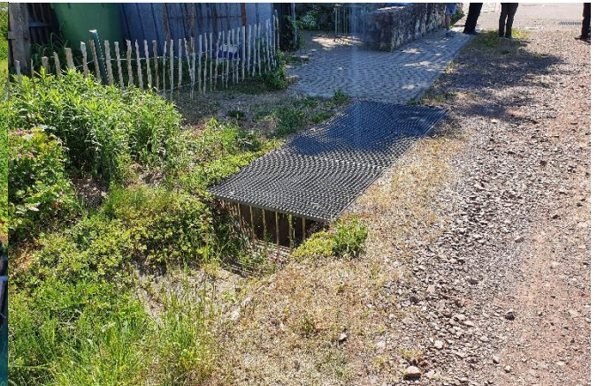
Blick auf das Einlassbauwerk in Richtung Ortslage
