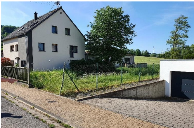
Brücke und gefährdete Garage (Blick gg. Fließrtg.)
