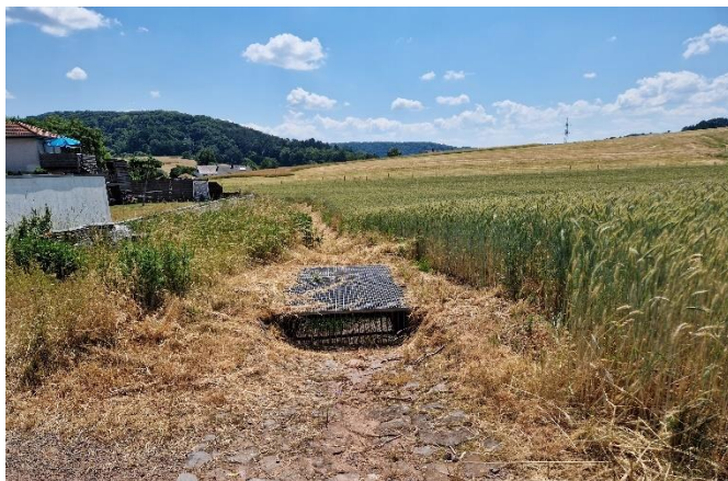
Einlassbauwerk am Weg und Graben hinter Bornstr. 13 A
