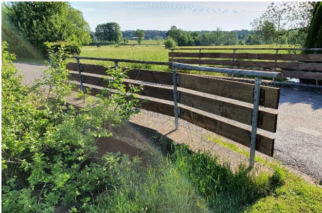
Brückenbauwerk: Blick in Fließrichtung
