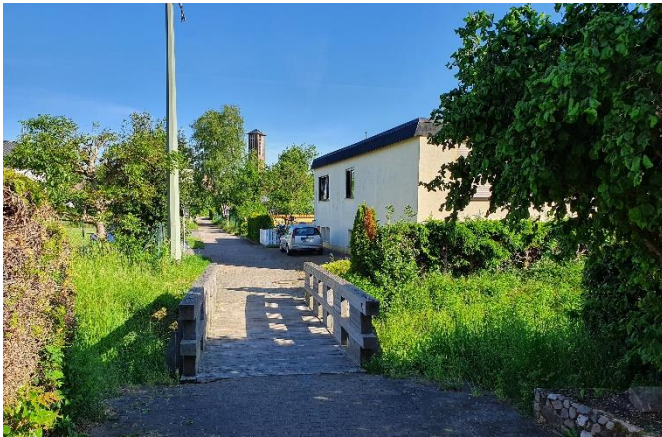
Brücke im Bereich „Im Schneppenbruch 13 bzw. 31“
