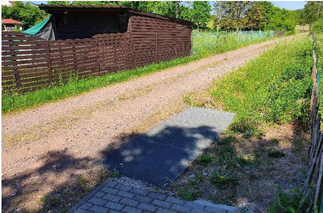
Einlassbauwerk am Weg, Blick gg. Fließrichtung
