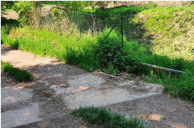
Abschlag im Weg zur Ableitung in das Becken
