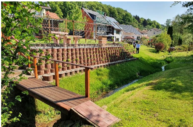
Private Brücken über den Bachlauf
