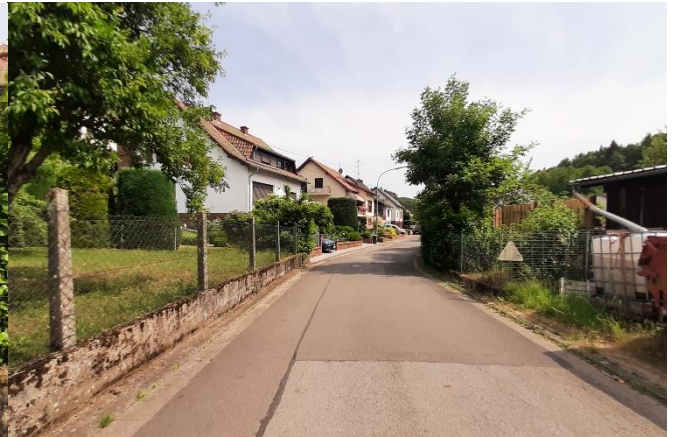
Straße „Im Hof“: Einstau bei Überlastung der Verrohrung
