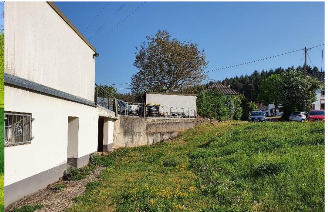
Hausbacher Str. 14: Tieferliegender Bereich am Bachauslass
