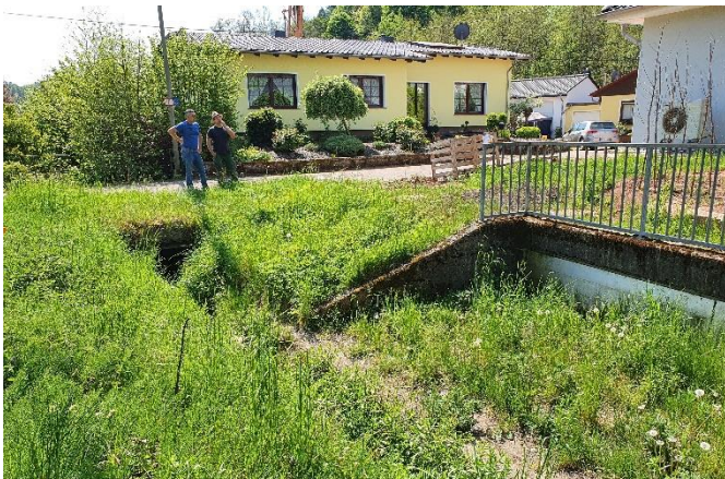
RÜ des EVS unmittelbar am Bachdurchlass in der Straße
