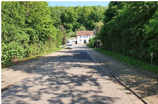
Straße „Weiherfeld im Bereich des Bachdurchlasses
