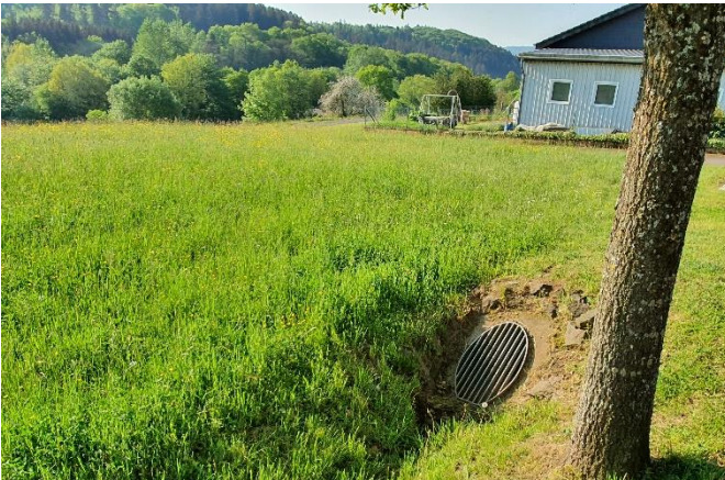
Graben und Einlassbauwerk an der L 374 vor der Bebauung
