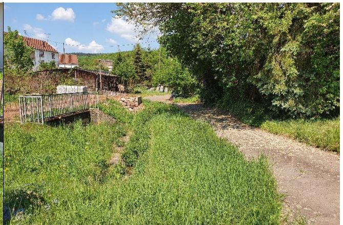
Blick von der Straße auf RÜ und den Bach (gg. Fließrtg.)
