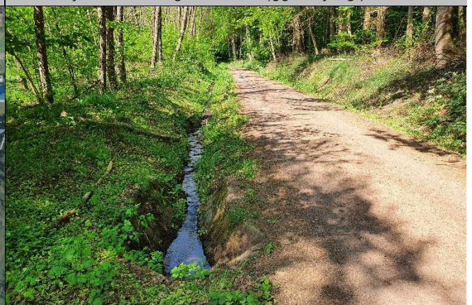
Bachlauf vor dem Wegedurchlass (gg. Fließrtg.)
