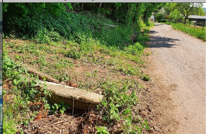
Durchlass am Wegeseitengraben vor der Bebauung
