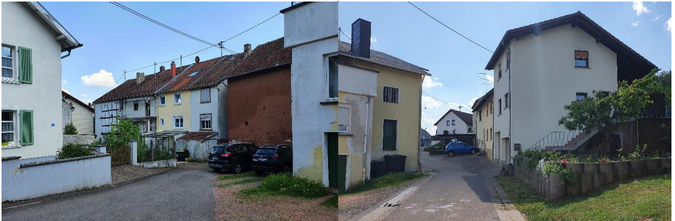
Tieferliegender Bereich rückseitig der Friedhofstraße | Straße „Zur Bornwiese“: Blick Richtung Friedhofstraße
