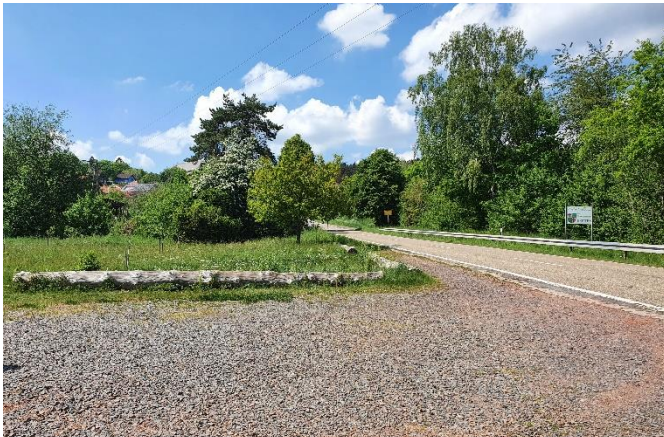
L 374 und möglicher Standort des neuen Feuerwehrhauses
