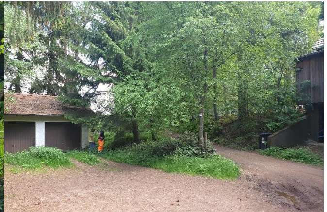
Bachverrohrung im Bereich Heisbornstraße 11 A
