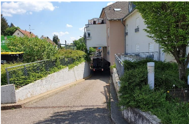
Zufahrt zum Kellergeschoss
