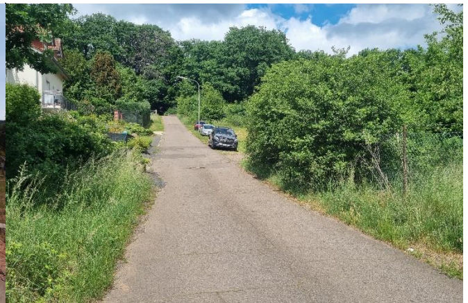
„Auf Grauenthal“, Rückhaltebecken rechts der Straße
