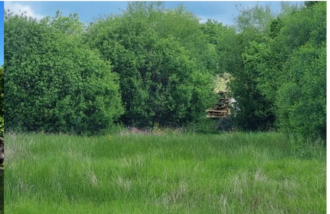
Rückhaltebecken und Einlassbauwerk
