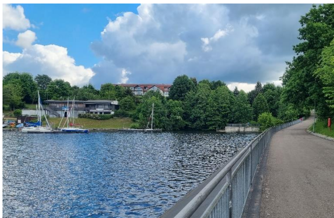
Staudamm, Blickrichtung: Drosselbauwerk
