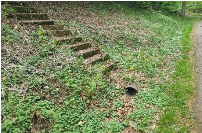
Wegeseitiger Graben und Durchlassbauwerk (bsph.)
