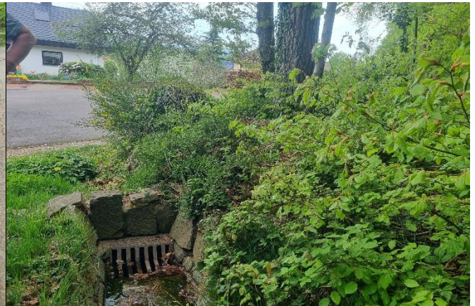
Entwässerungsgraben aus dem Wald, Einlass an Kurstr.
