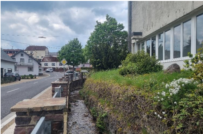
Fließabschnitt vor Verrohrung an Waldhölzbacher Straße
