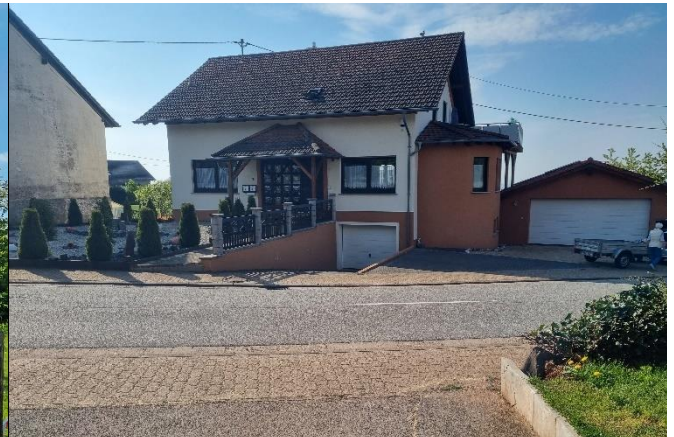
Betroffenes Objekt der Scheidener Straße
