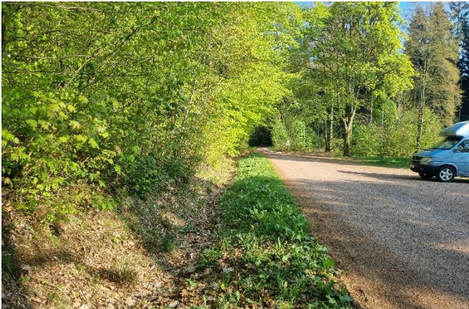
Wegeseitiger Entwässerungsgraben, Blick nach Norden
