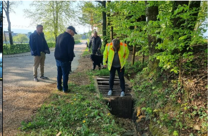
Einlassbauwerk, Blick nach Süden
