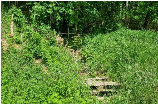
Blick in die Weckeltergräth, Abschnitt vor Einlassbauwerk
