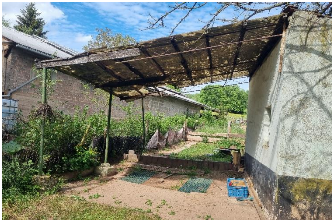
Graben d. Außengebietsentwässerung hinter der Bebauung
