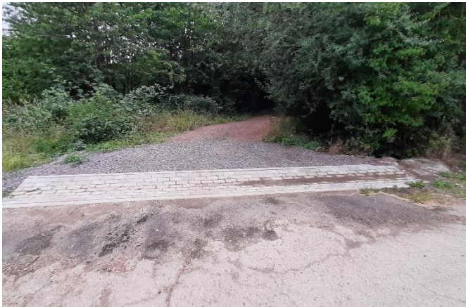
Rinne zur Ableitung von Abfluss zwischen Teer- und Waldweg
