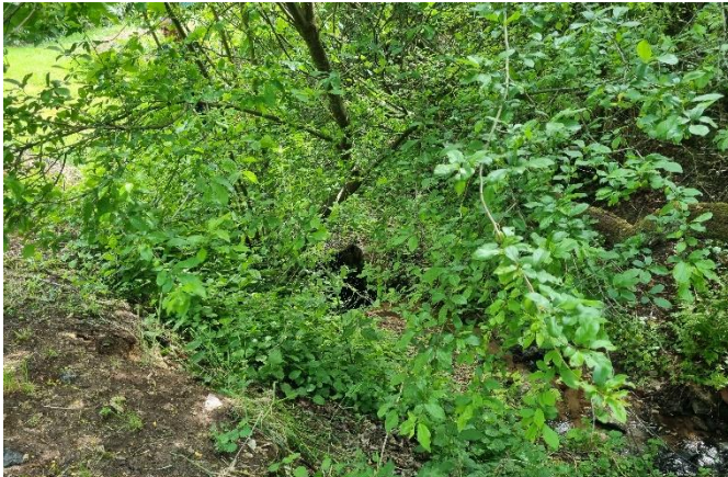
Einlassbereich des Mühlenbaches in die Verrohrung
