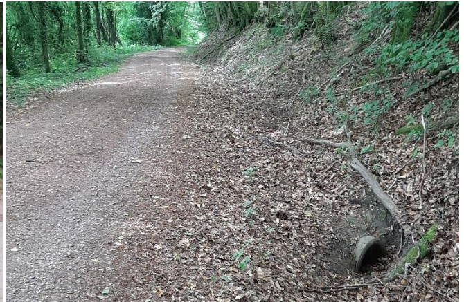
Bergseitige Entwässerungseinrichtungen am Waldweg
