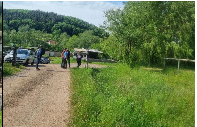
Graben und Einlassbauwerk, Blick nach Nordwesten
