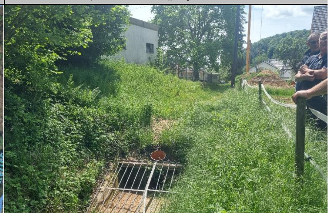
Einlassbauwerk, oberhalb von „Auf Kellerchen“
