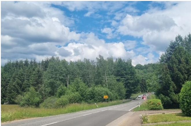
Straßendurchlass an der Mitlosheimer Straße
