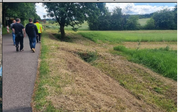
Entwässerungsgräben, in Verlängerung der Str. Flürchen
