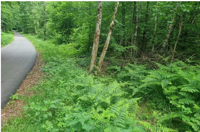
Wegeseitiger Graben am Waldweg
