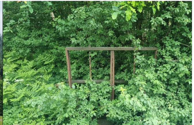
Anlage am Lannebach
