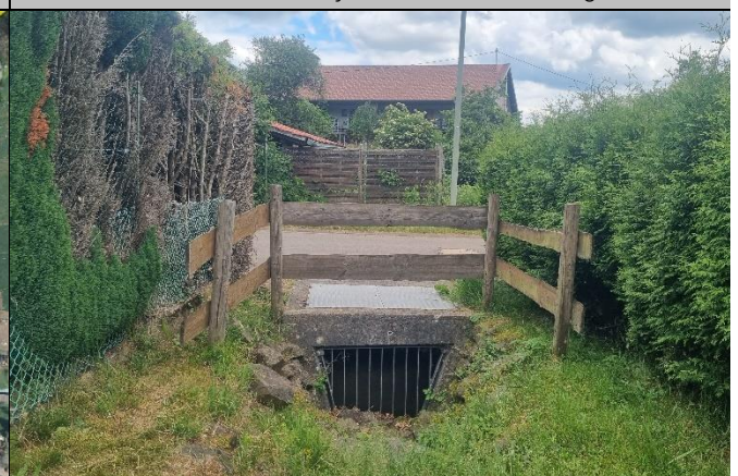
Einlassbauwerk an der Straße Schwarzwälderweg
