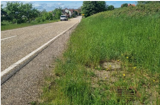
Einlassschacht an der Landesstraße, beispielhaft
