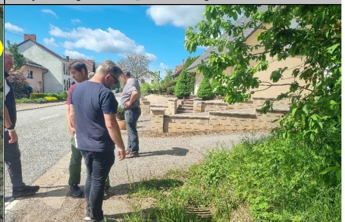
Straßenseitiger Einlass „Am Südhang“
