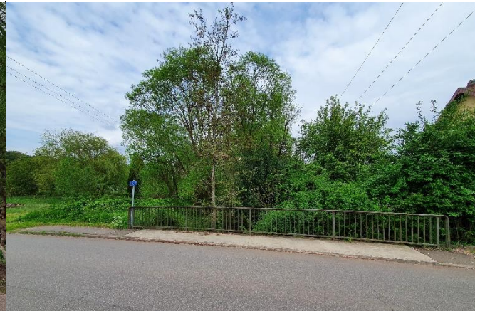
Brücke über den Bach, Blick gg. die Fließrichtung
