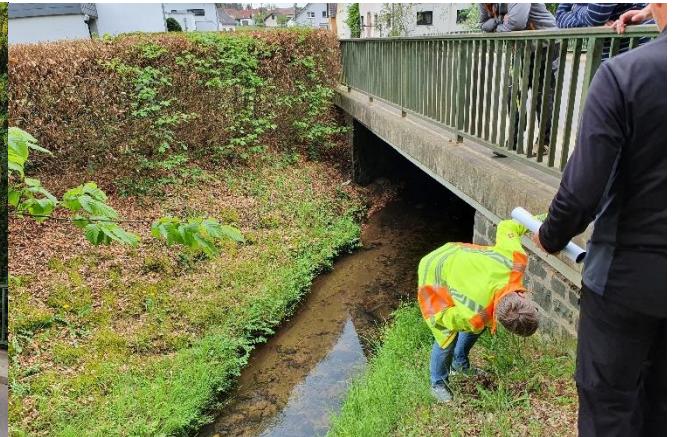
Brückenbauwerk Bachemer Straße in Fließrichtung
