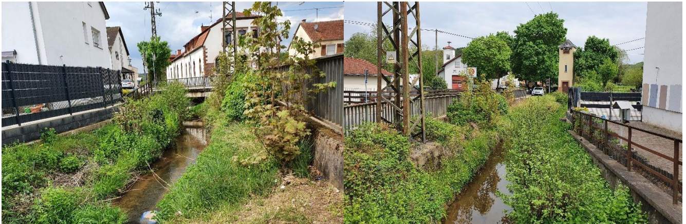
Blick entlang des Dellbaches zur Provinzialstraße
