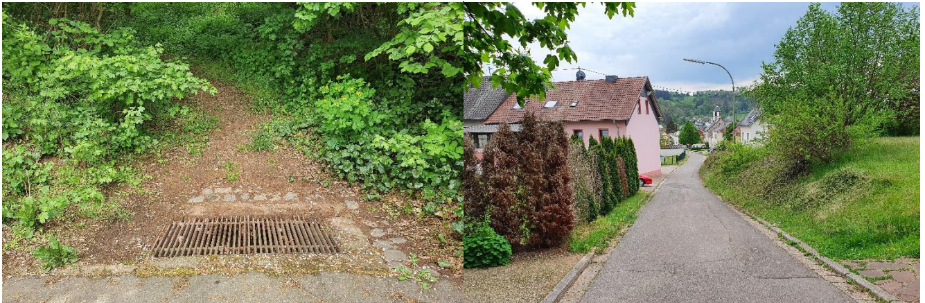
Einlassbauwerk am Übergang zum Wirtschaftsweg
