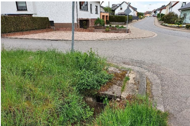
Einlassbauwerk im Bereich Bachemer Straße 52
