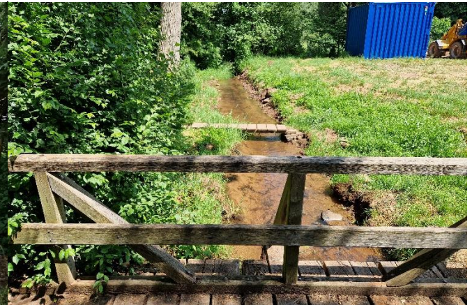
Blick von der Brücke auf das Gewässer
