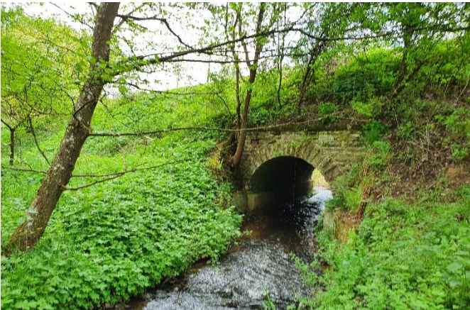
Blick in Fließrtg. auf den Durchlass im alten Bahndamm
