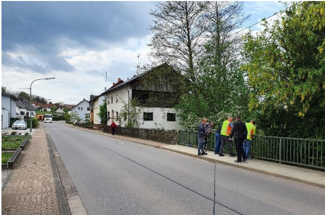
Bachemer Straße über dem Dellbach
