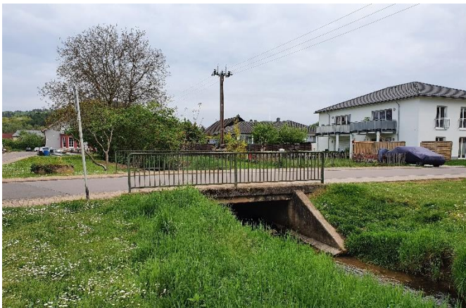
Blick gg. die Fließrtg. auf das Brückenbauwerk
